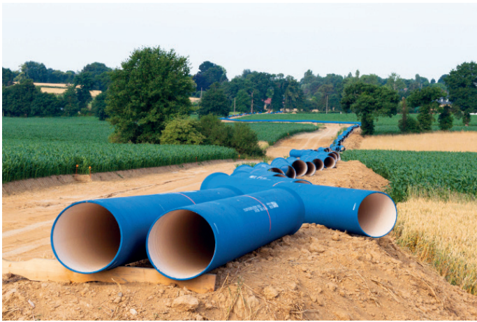
L'Aqueduc Vilaine Atlantique en cours de travaux.
