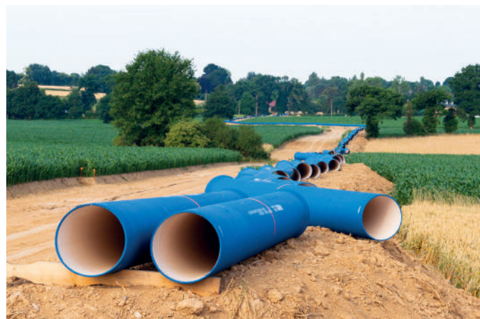
L'Aqueduc Vilaine Atlantique en cours de travaux.
