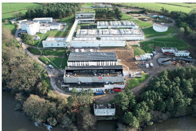
Travaux de l'usine
