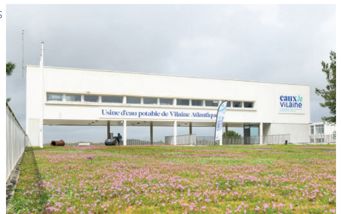
Usine d'eau potable de Vilaine Atlantique
