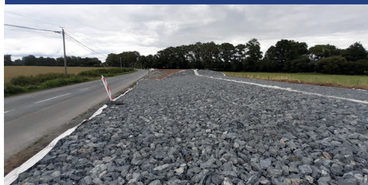
Ouvrage hydraulique de prévention des inondations
