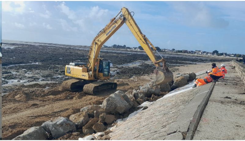
Eaux & Vilaine à pied d'œuvre pour sécuriser l'ouvrage fragilisé suite à la tempête Céline, en partenariat avec la Mairie de Damgan et la Communauté de Communes Arc Sud Bretagne.
