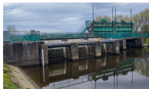
Vannage de l'Isac, ouvrage géré par Eaux & Vilaine sur le territoire gemapien du Syndicat Chère Don Isac.
