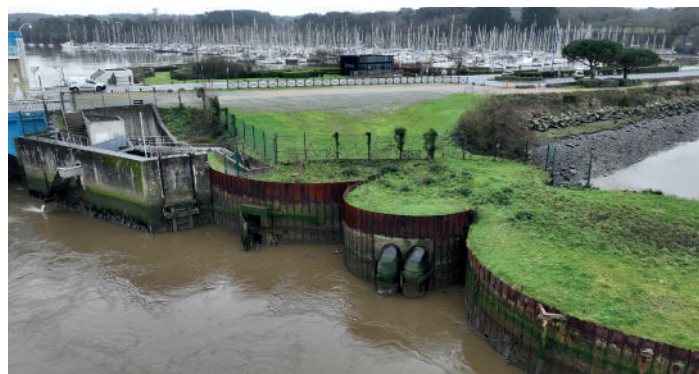
Gabions, barrage d'Arzal (56)
