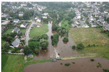
Ouvrage de ralentissement des crues de la Chère
