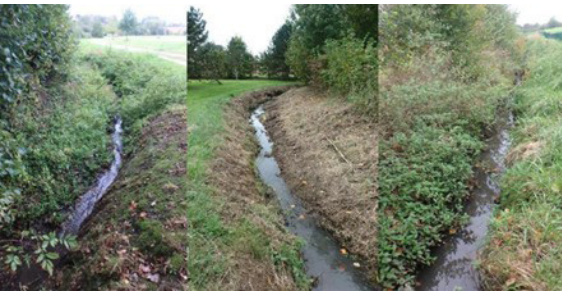
Cours d'eau avant travaux : le tracé est rectiligne et encaissé signe d'un cours d'eau dégradé
