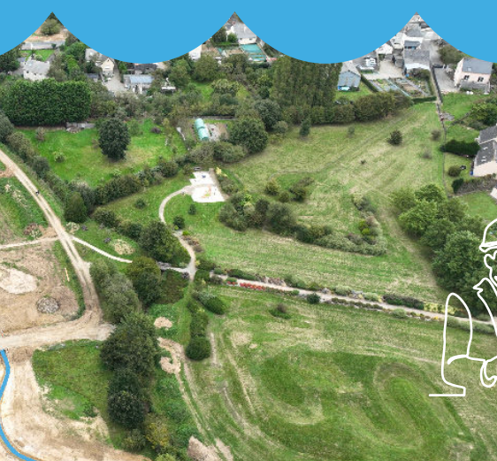
Phase chantier : cours d'eau restauré
