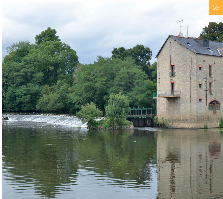
Barrage de la Courbe sur la Vilaine, Bourg-des-Comptes (35)
