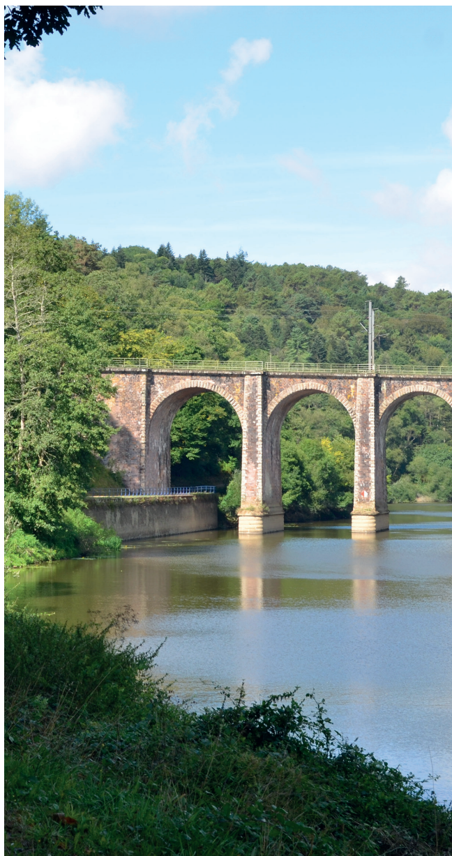
Pont des Corbinières / Guïpry-Messac (35).
