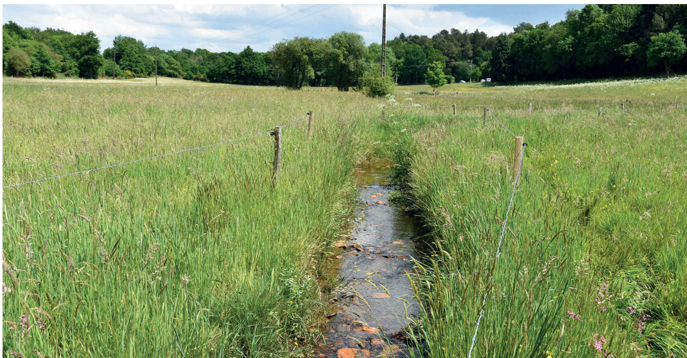
Remise du cours d'eau dans son lit d'origine / Ruisseau de l'Étang de St-Just (35)
