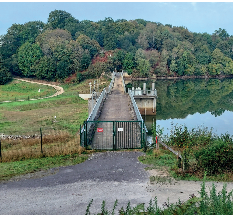
Accès au barrage de la Cantache
