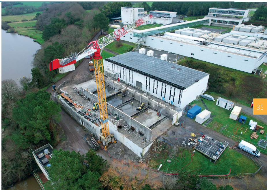
Travaux d'extension de l'usine d'eau potable Vilaine Atlantique, à Férel (56)
