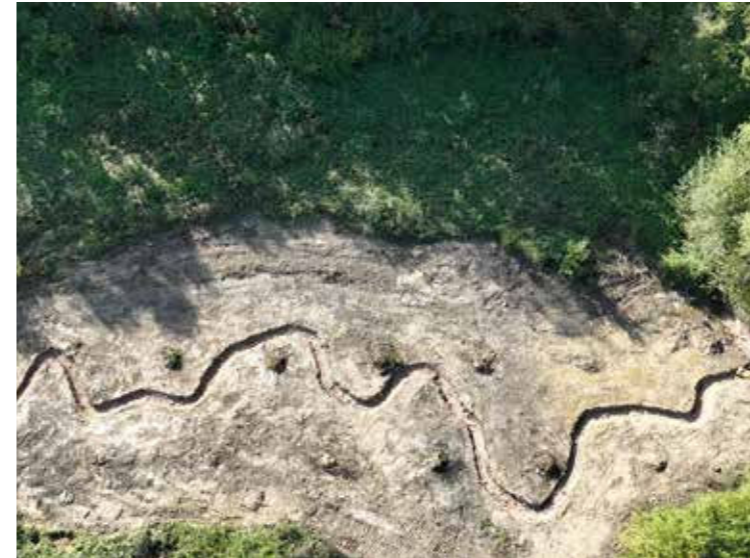
Travaux sur un affluent du ruisseau de Bodin, Orgères (35)
