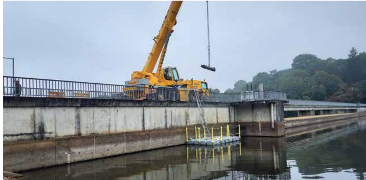
Dépose d'un vérin sur le clapet du barrage de la Cantache (35).
