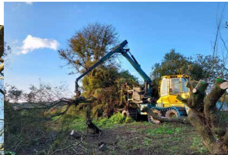
Chantier de défrichement à Glénac
