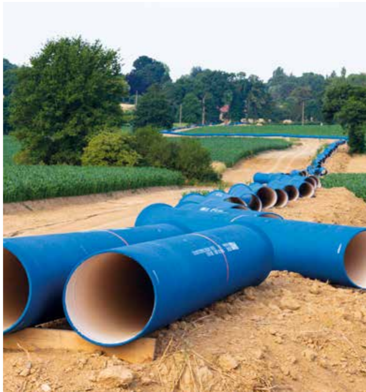
Chantier Aqueduc Vilaine Atlantique
