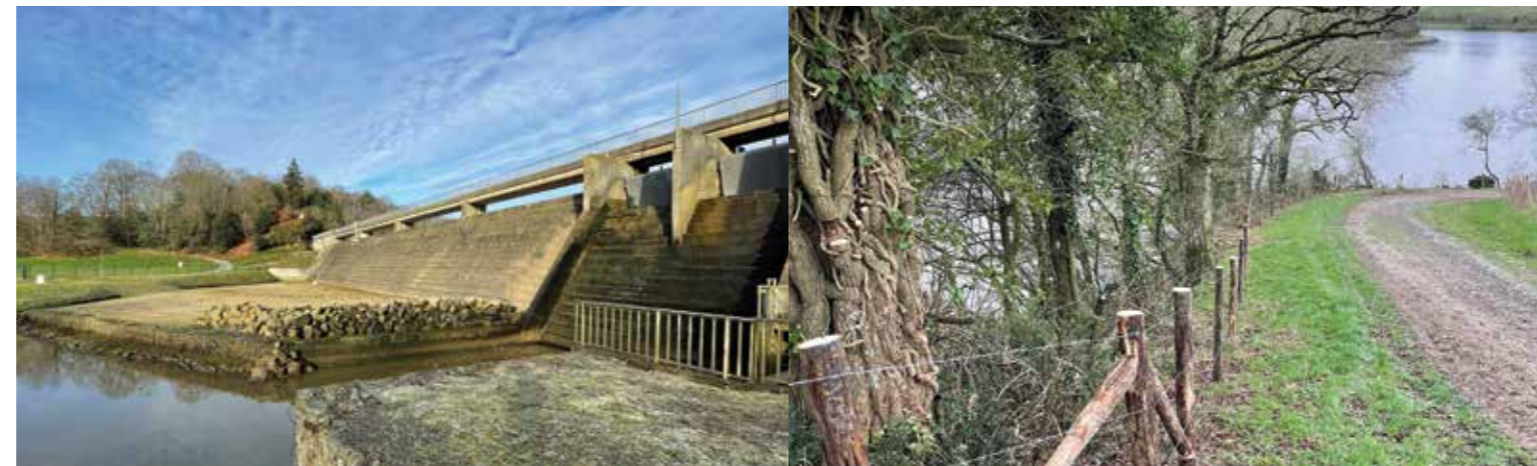
Réfection de la plateforme de déversoir du barrage de la Cantache
