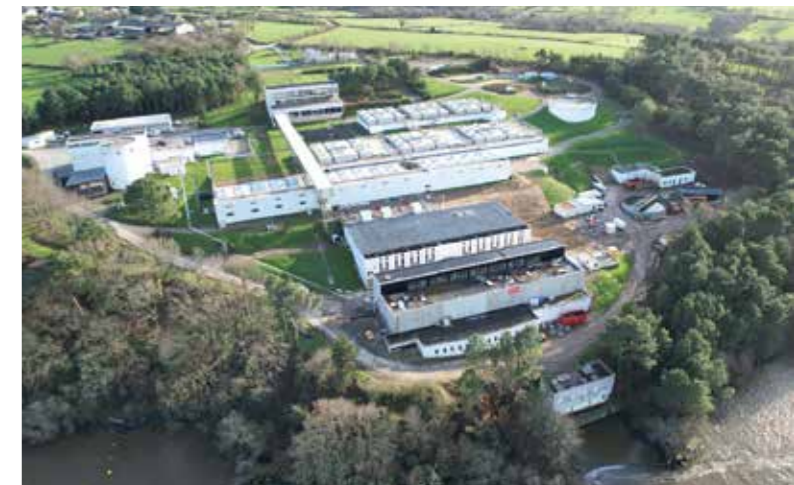
Usine d'eau potable de Vilaine Atlantique
