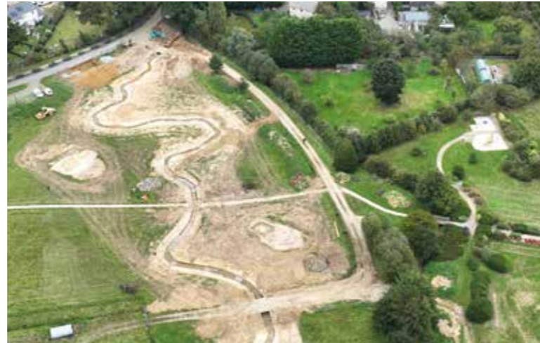
Chantier de renaturation sur le site de La Vallée, Taillis (35).
