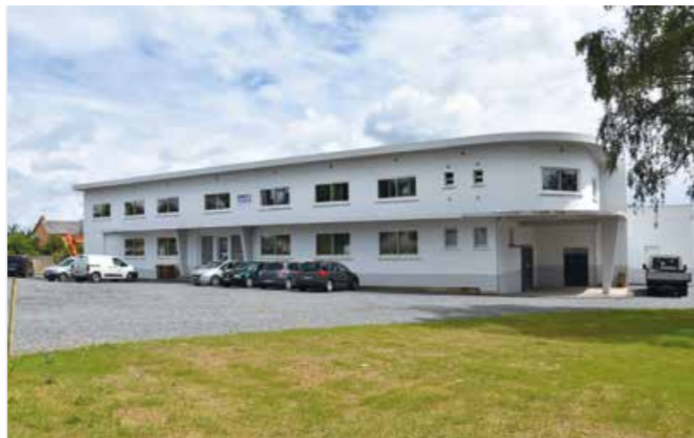
Nouveaux locaux de l'Unité de Gestion Vilaine Aval, Redon (35)
