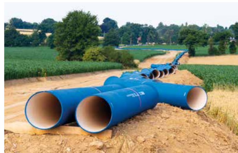
L'Aqueduc Vilaine Atlantique : un chantier d'envergure qui se termine
