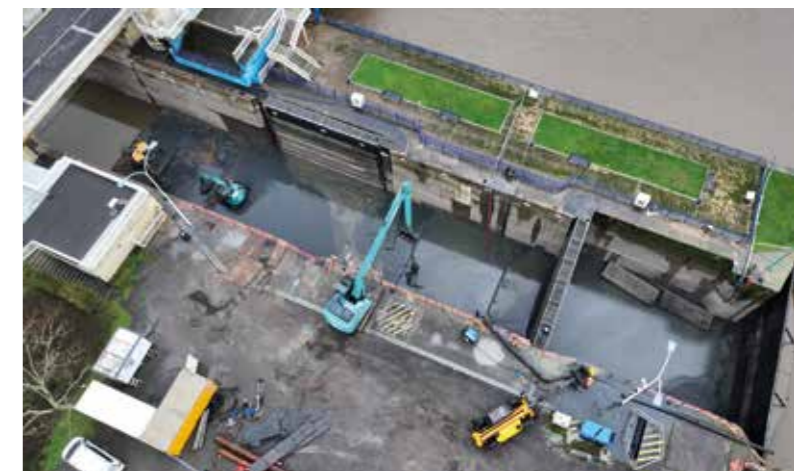
Mise à sec de l'écluse au barrage d'Arzal, janvier 2023.
