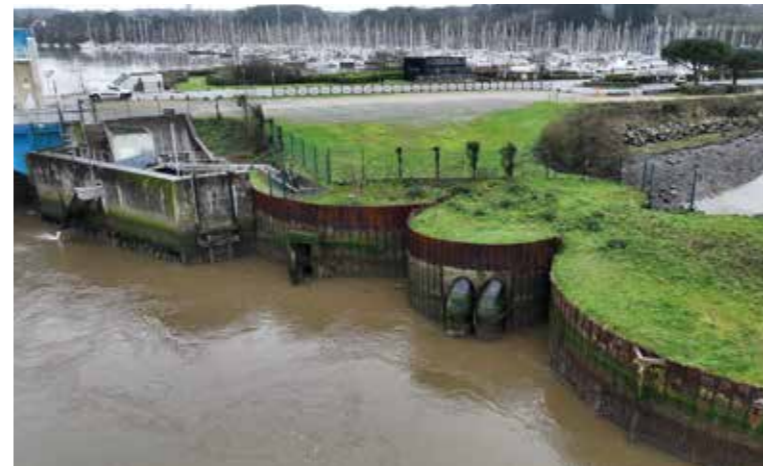
Gabions bientôt rénovés, barrage d'Arzal (56)
