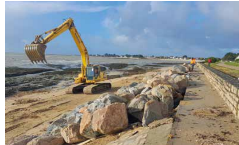
Enrochement de la digue de la grande place de Damgan
