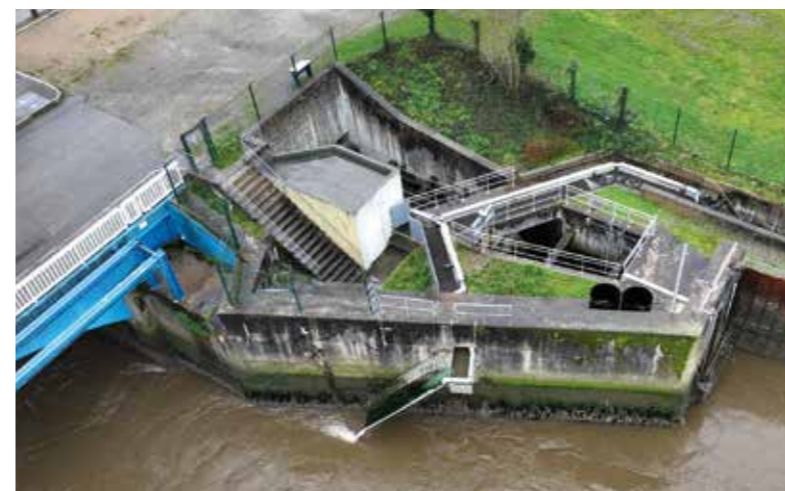
Passé à anguilles, écluse d'Arzal (56)
