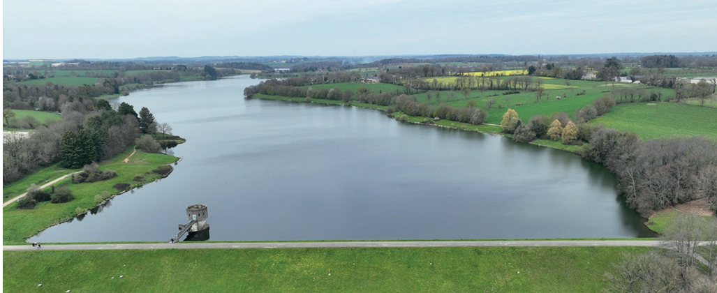
Barrage de la Valière
