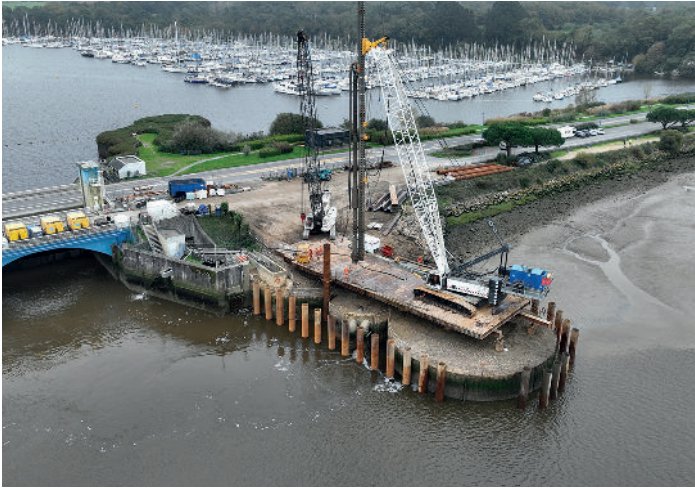
Rénovation des gabions du barrage d'Arzal (56)
